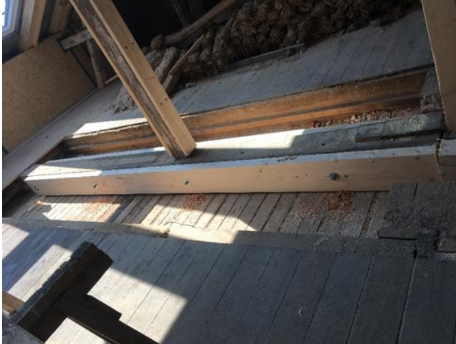
Nachträglich eingebaute Verstärkungen
