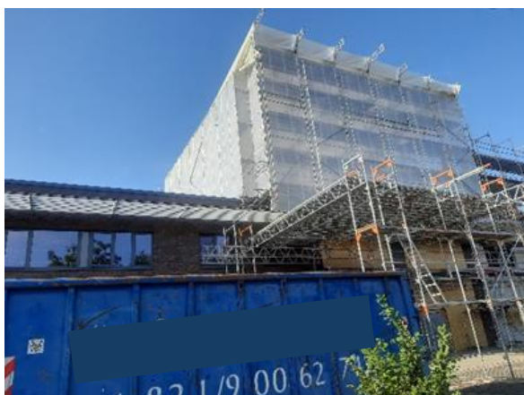
aufgebautes Gerüst
