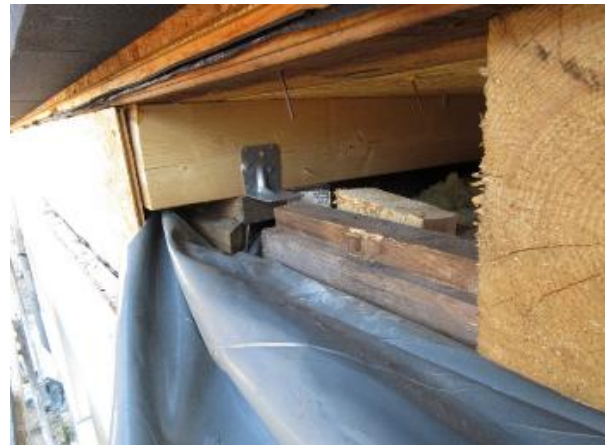
Unzureichender Holzbauanschluss
