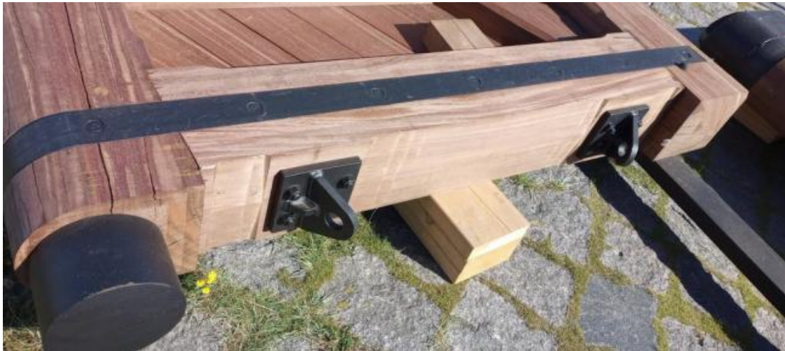
Foto: liegender Torflügel vor dem Einbau
